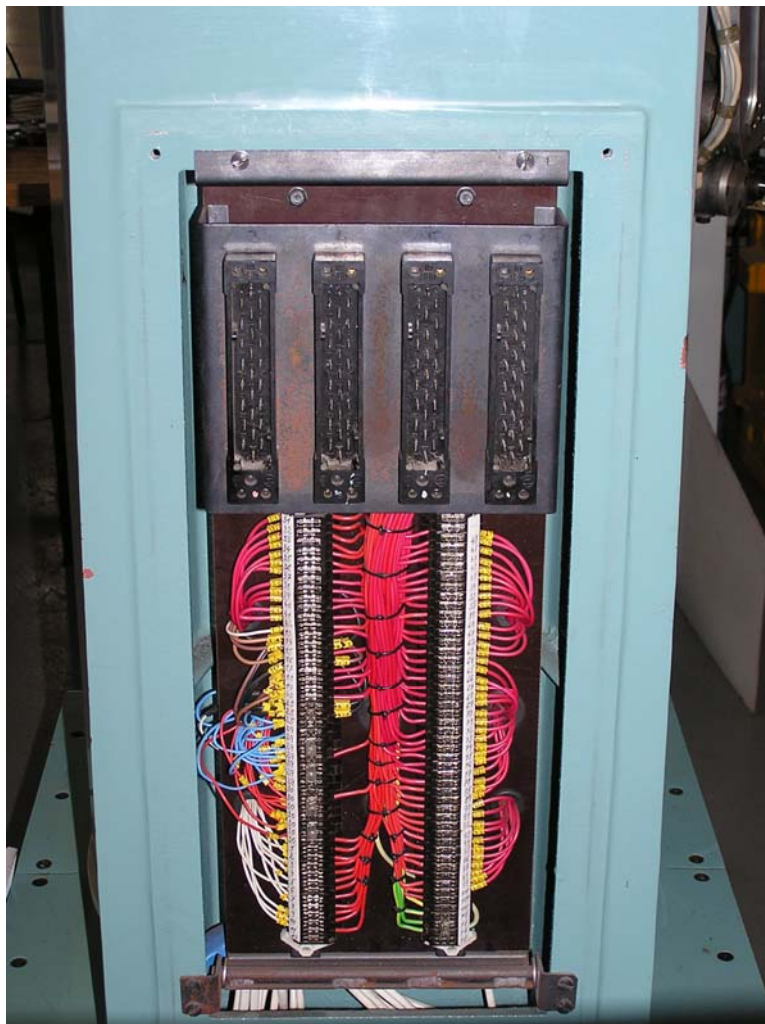
Obrázek 4 - Systémové konektory XP3, XP4, XP5, XP2 a hlavní rozvaděč XT3
